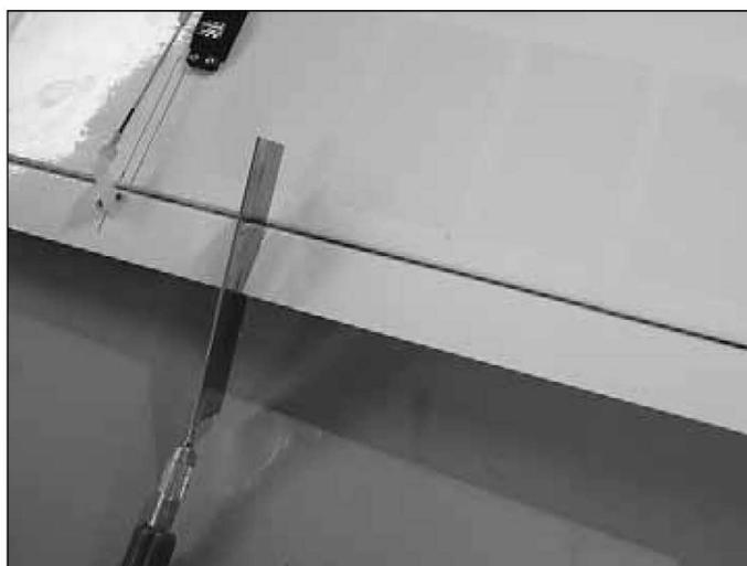
1. Trace uma linha no aileron distante 254mm de sua extremidade na raiz da asa e use uma serra de hobby para cortar o aileron nessa linha.
